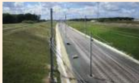
La LGV a restreint la capacité d'infiltration des eaux de pluie.
