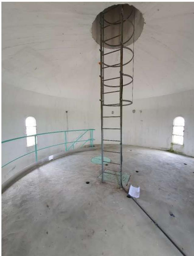
Le château d'eau de Pussigny a une hauteur de 30 mètres et contient une réserve de 300 m<sup>3</sup> d'eau. Il nous aura fallu monter 146 marches et une échelle pour observer cette cuve.
